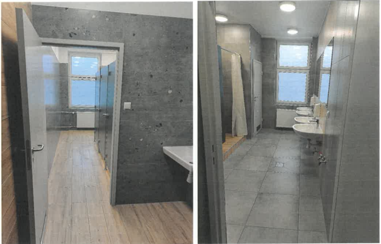
Zdjęcie 2, 3. Widok wyremontowanych łazienek
