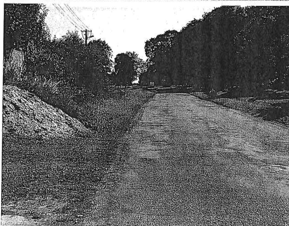
Fot. 1 Stan Istniejący
