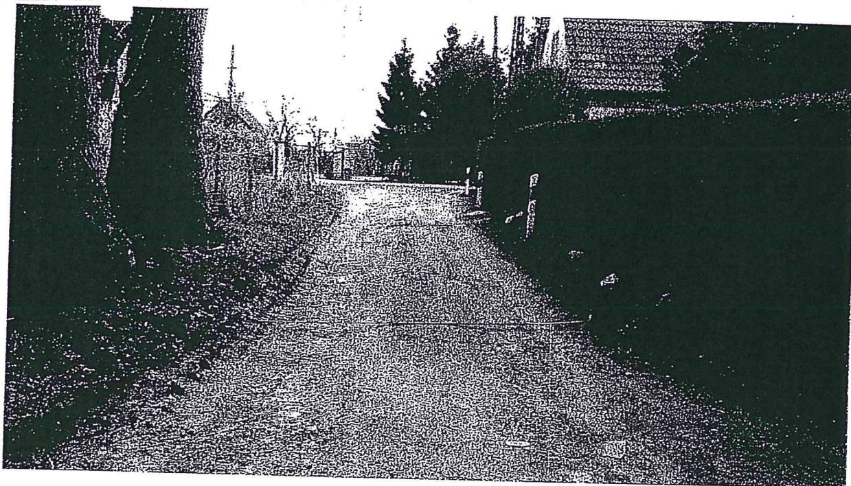
Zdjęcie 1 Widok ogólny drogi
