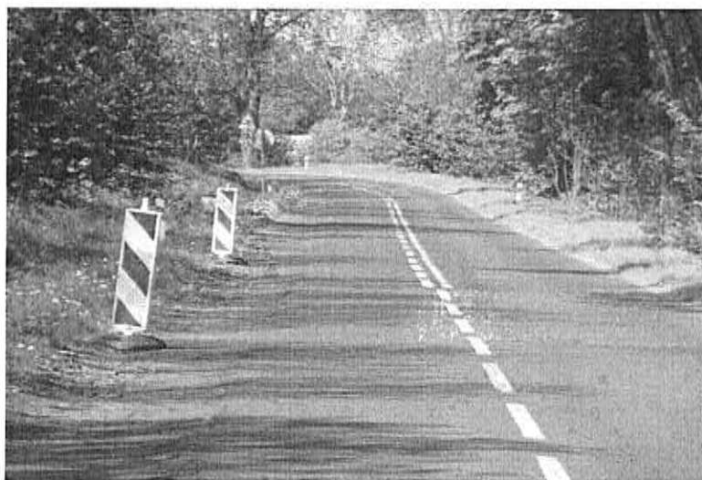
Fotografia 2 Stan istniejący drogi
