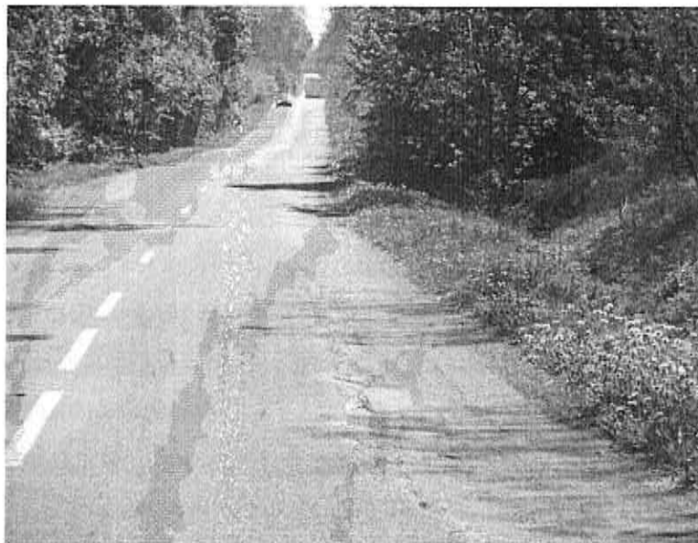
Fotografia 3 Stan Istniejący drogi.
