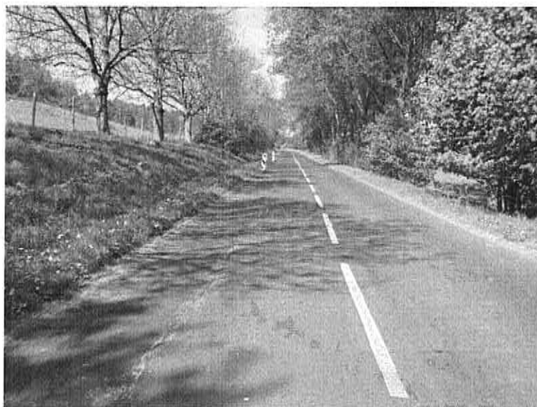
Fotografia 1 Stan istniejący drogi
