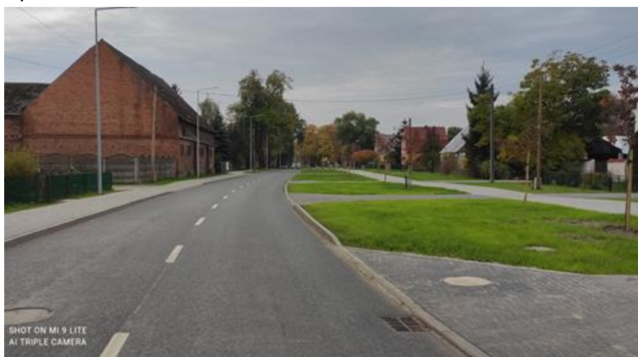
Na zdjęciu przedstawiono przebudowaną drogę
