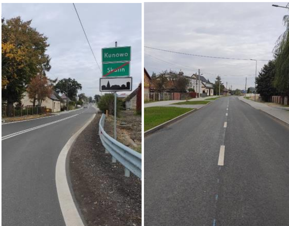
Na dwóch zdjęciach przedstawiono przebudowaną drogę
