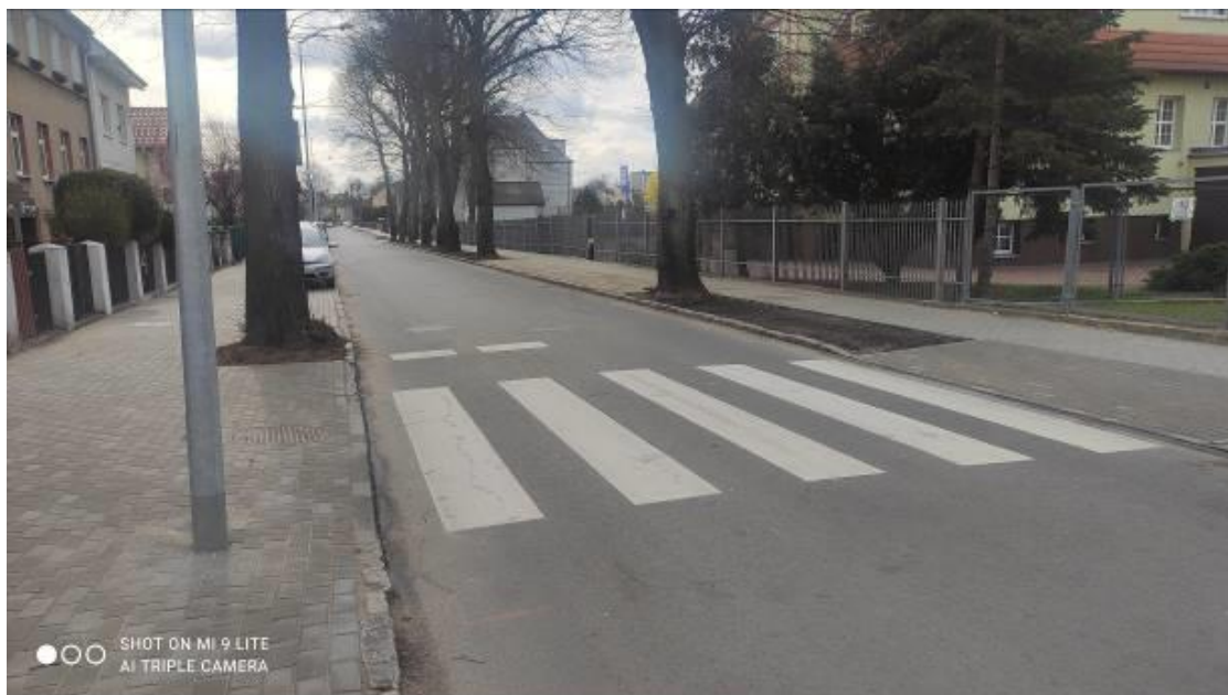
Na zdjęciu przedstawiono przebudowaną drogę
