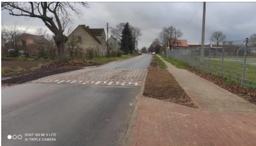
Na zdjęciu przedstawiono przebudowaną drogę
