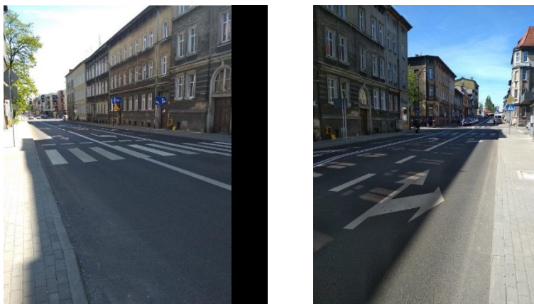
Na dwóch zdjęciach przedstawiono przebudowaną drogę
